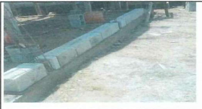
Foto 6: Se espera que con el remozamiento se finalice la obra.
